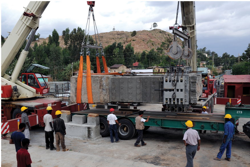
Fig. 1 : Ré-installation de l'obélisque à Axoum, 2008. Photo: wikimedia commons. https://commons.wikimedia.org/wiki/File:Aksum-107557.jpg .
