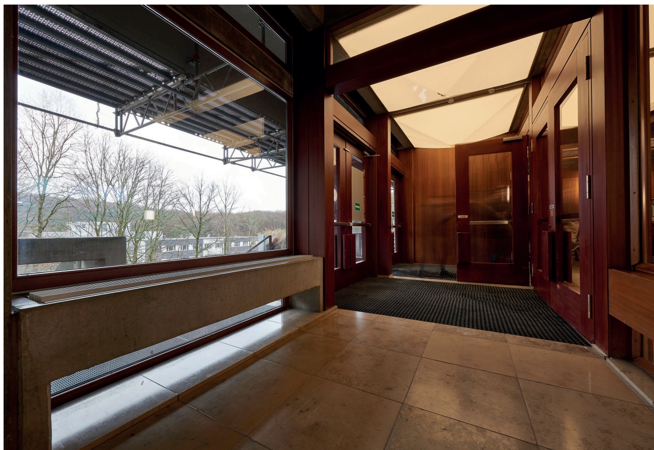
Fig.24 Hintereingang der Mensa mit Schutzgerüst 2018 © Marco Kany
