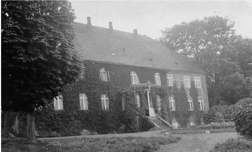
Abb.30: Das Gutshaus in Schlakendorf
