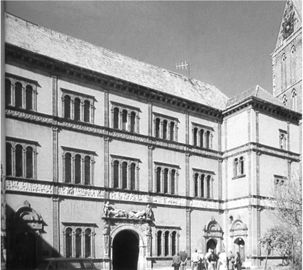
Abb.15: Altes Gymnasium zu Wismar
