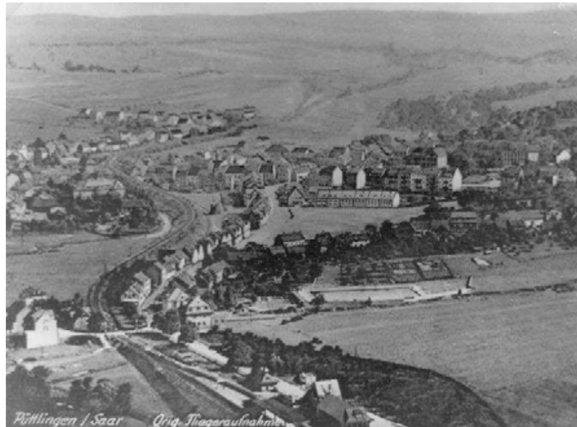
Abb. 6: Luftaufnahme (Ansichtskarte) von Püttlingen aus der Zeit nach 1935, die die durch den Bahndamm zerschnittene Ortsmitte mit Rathaus, Schlöbchen und Hexenturm zeigt (Stadtarchiv Püttlingen).
