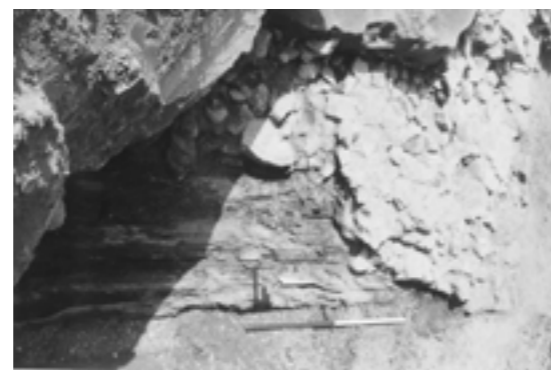
Abb. 7: Die Holzkonstruktion unter der Ostmauer der Burg (Bereich der Nordost-Ecke); Blickrichtung: Norden
