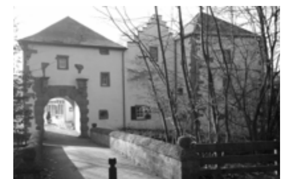
Abb. 3: Äußerer Torbau der Vorburg. Rechts ist der Fünfeckturm zu erkennen (Aufnahme des Autors).
