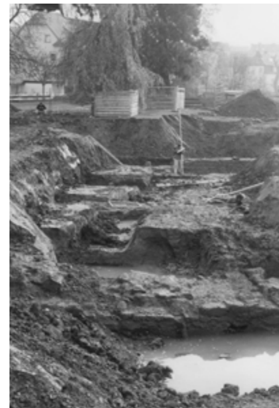
Abb. 1: Blick über das Grabungsgelände in Richtung Süden; vorne die Nordmauer, dann die beiden Quermauern im Innenraum, ganz hinten die Südmauer der Burg
